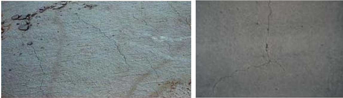
Φωτ 1: Ρηγμάτωση σκυροδέματος σε πλαστική κατάσταση
